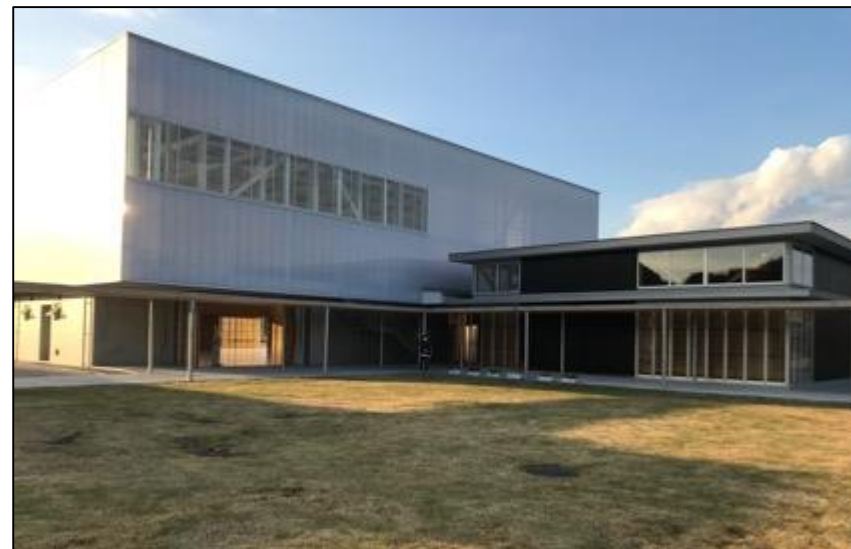
体育館・小体育館（外観）
