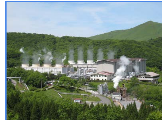
日本最大の地熱発電所 八丁原地熱発電所 (経済産業省 資源エネルギー庁 公式サイトより)
